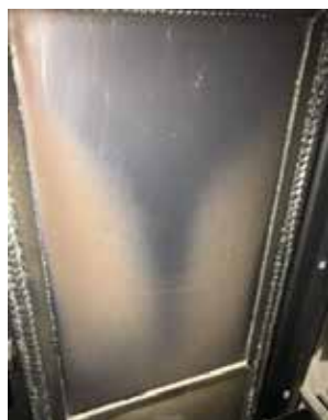
Antes de la limpieza
