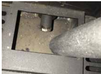
Após a limpeza
