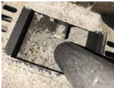
Antes de la limpieza
